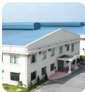
Nhà máy xưởng K5
