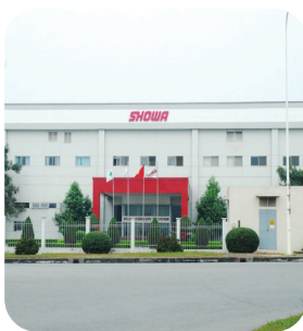
Công ty VINASHOWA
